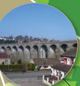
Hengoed Viaduct Traphont Hengoed
